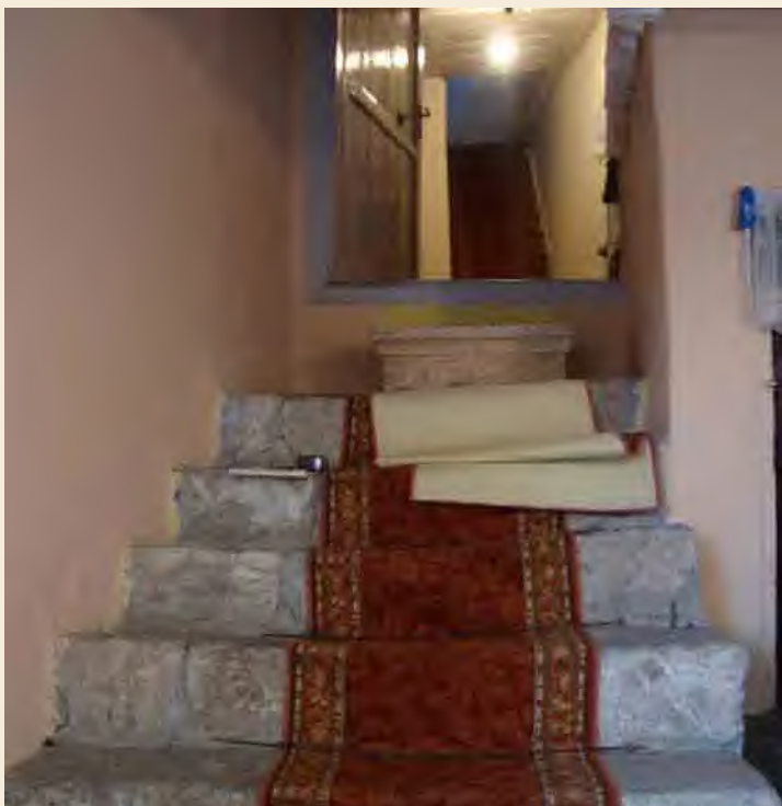
SHKALLËT NGA GURI STONE STAIRS
