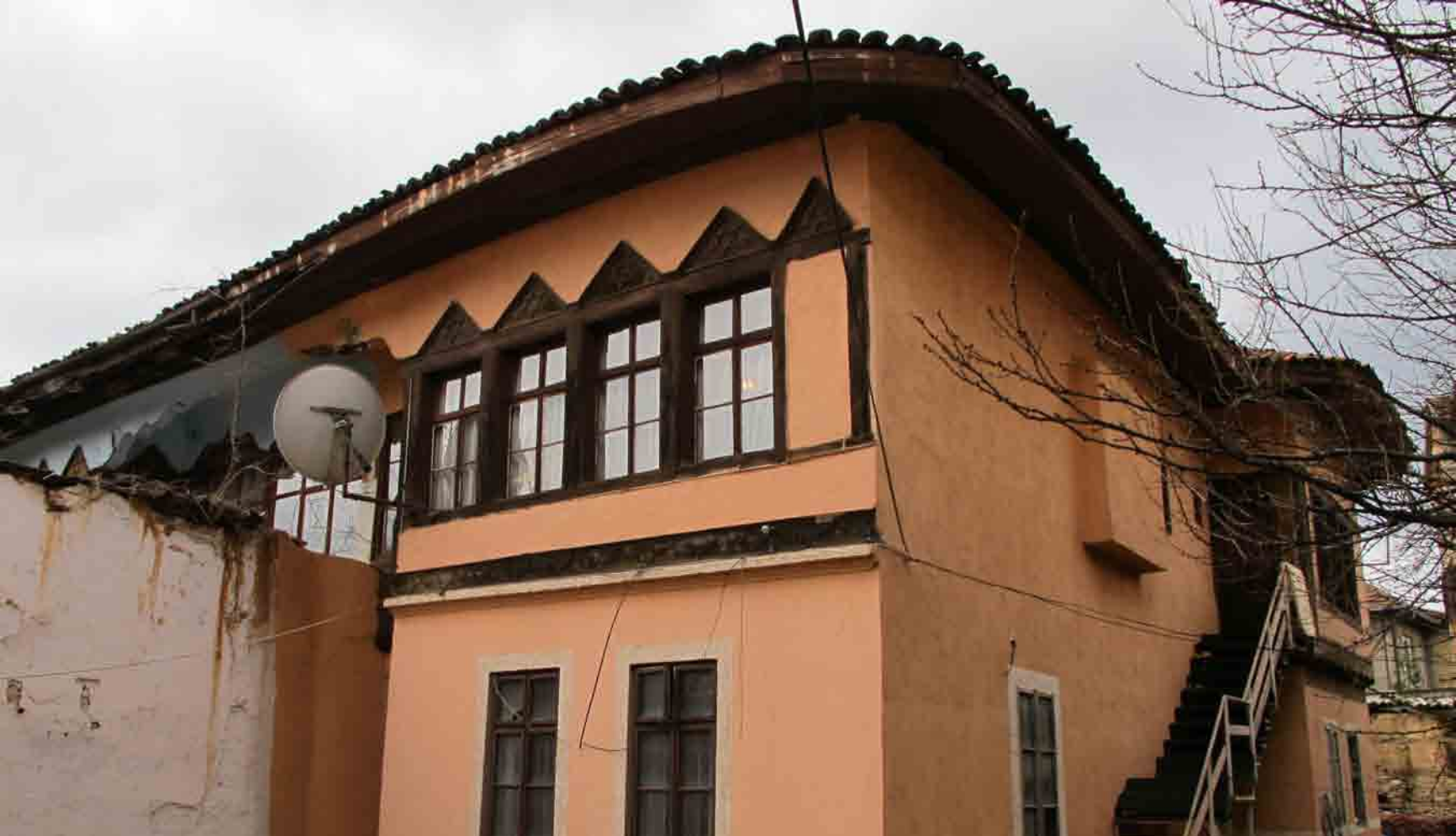
SHTËPIA E ADEM AGA GJONIT ADEM AGA GJON HOUSE
