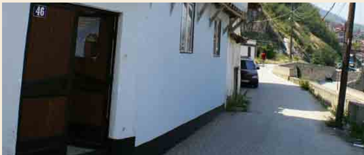
FASADA ANËSORE SIDE VIEW
