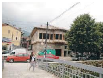
Rekonstruimi i shtëpisë së Shuaip Pashës, 2011 Reconstruction of Shuaip Pasha house, 2011
