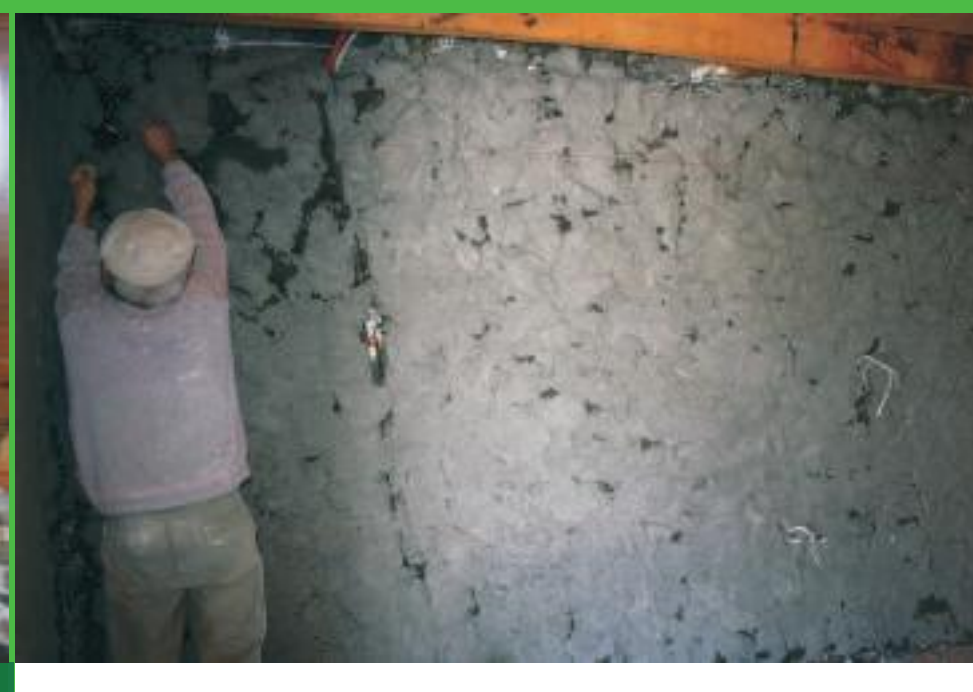
Mbushja e fugave rreth gurëve dhe suvatimi me llaç janë disa prej teknikave tradicionale të përdorura gjatë restaurimit të kullës së Isufajve. Infills around stones and the plastering are some of the traditional techniques used in restoration of the Isufajs' Kulla.
