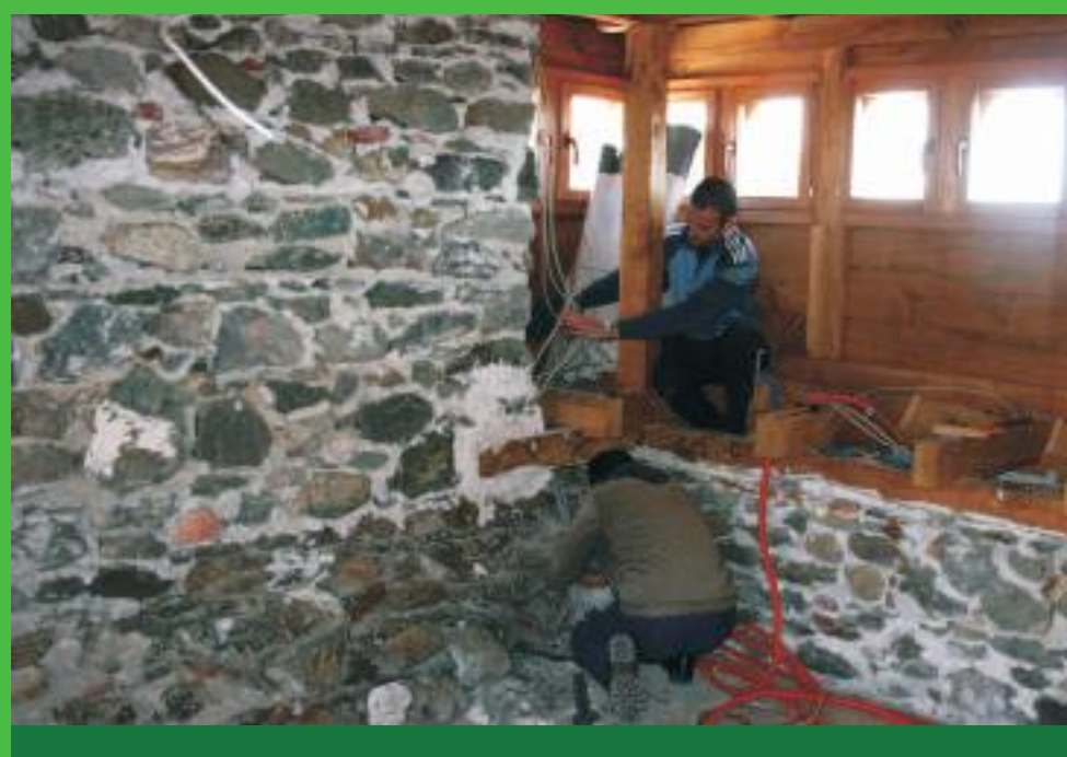
Mbushja e fugave rreth gurëve dhe suvatimi me llaç janë disa prej teknikave tradicionale të përdorura gjatë restaurimit të kullës së Isufajve. Infills around stones and the plastering are some of the traditional techniques used in restoration of the Isufajs' Kulla.
