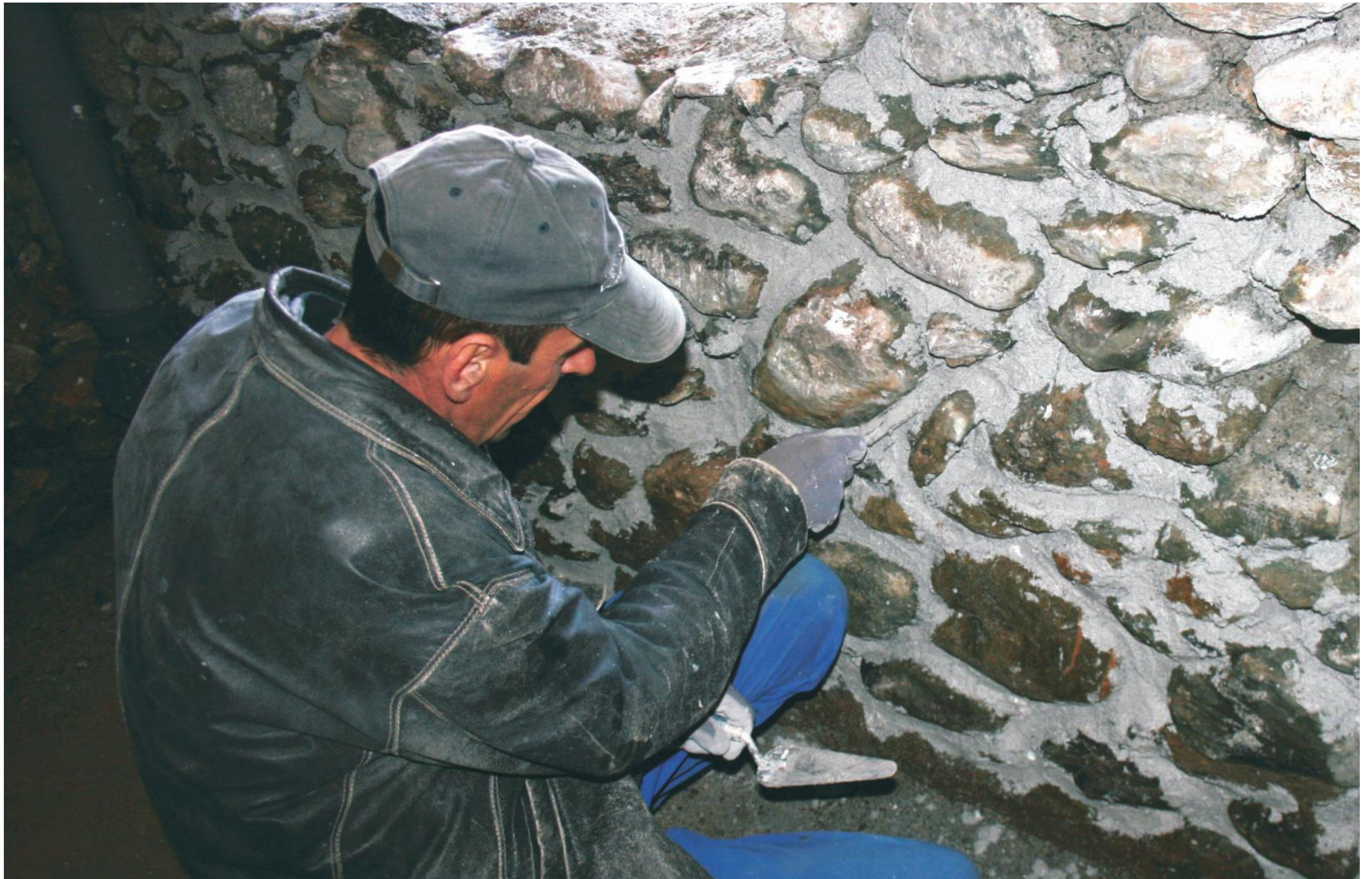
Mbushja e fugave rreth gurëve dhe suvatimi me llaç janë disa prej teknikave tradicionale të përdorura gjatë restaurimit të kullës së Isufajve. Infills around stones and the plastering are some of the traditional techniques used in restoration of the Isufajs' Kulla.
