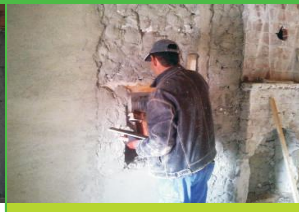
Mbushja e fugave rreth gurëve dhe suvatimi me llaç janë disa prej teknikave tradicionale të përdorura gjatë restaurimit të kullës së Isufajve. Infills around stones and the plastering are some of the traditional techniques used in restoration of the Isufajs' Kulla.
